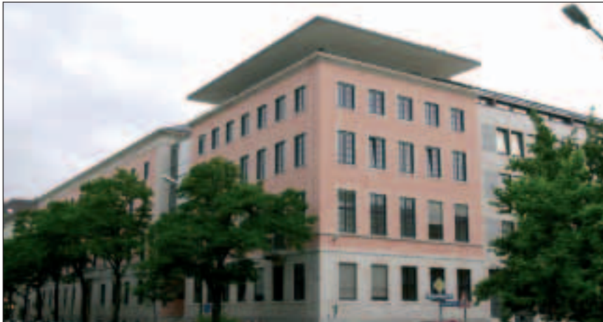
Die 'Steckdose Europas': Eingang zur E.ON Energie AG Zentrale.
